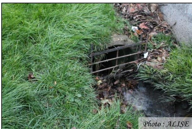
Photo n°69 Observation de rejet d'eaux usées dans la canalisation rue de l'Isle
