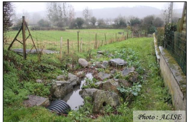
Photo n°64 Sortie de canalisation et enrochement dans le chemin
